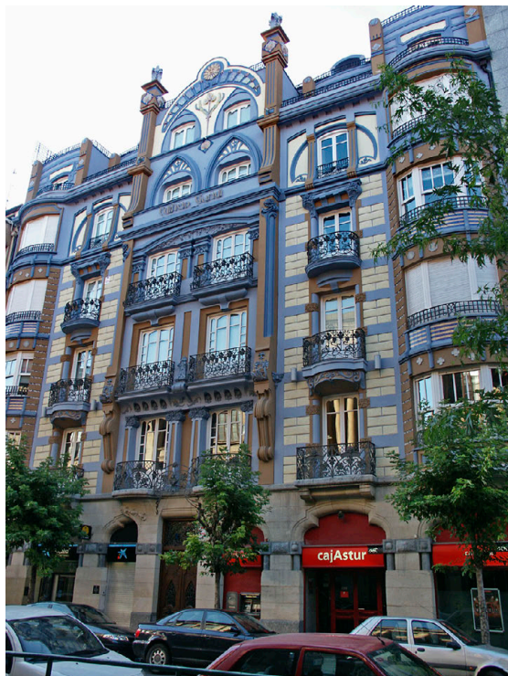
Fig. 3. Casa de Francisco Usobiaga . Maestro de obras José Bilbao Lopategui. 1902. Calle Licenciado Poza nº 2. Bilbao
