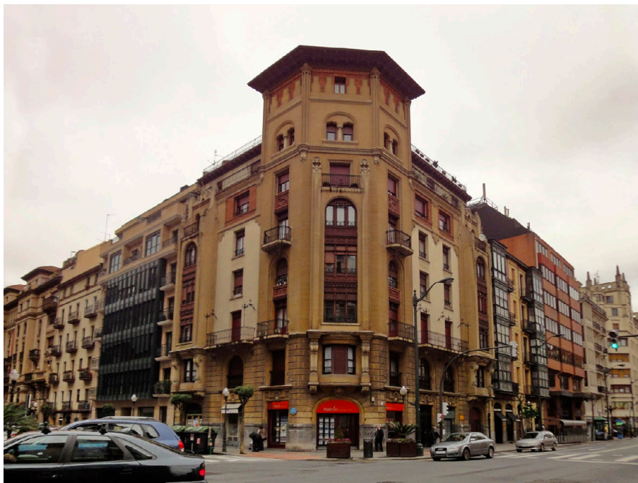
Fig. 6. Casa de Santiago Arana . Arquitecto Ignacio Smith Ibarra. 1925. Calle Alameda Recalde n° 22. Bilbao
