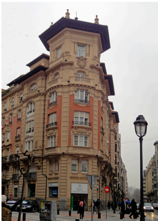
Fig. 12. Casa de Patricio Bilbao Goicoechea . Arquitecto Tomás Bilbao. 1918. Calle Ercilla nº 20. Bilbao
