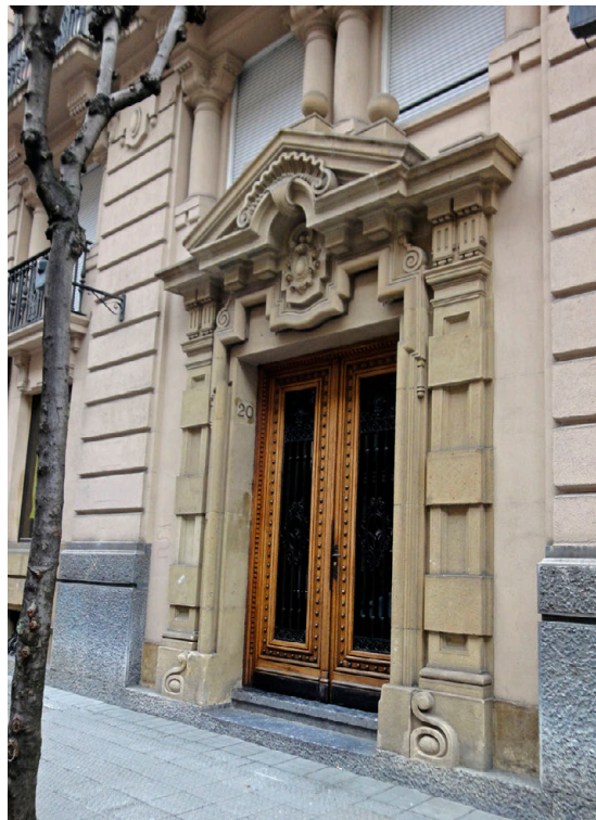
Fig. 15. Ingreso al portal de la casa de Patricio Bilbao Goicoechea. Arquitecto Tomás Bilbao. 1918. Calle Ercilla nº 20. Bilbao
