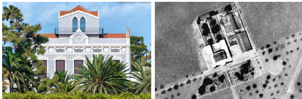
Fig. 5, izq. Villa María: fachada principal (Fuente: José Antonio Rodríguez Martín). Derecha, ortofoto aérea del Vuelo Ruiz de Alda del año 1929, la residencia principal se ubica en el extremo inferior izquierdo, agrupándose a la derecha las edificaciones secundarias (Fuente: Confederación Hidrográfica del Segura)
