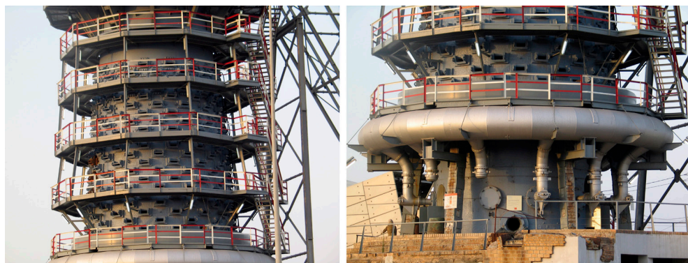
Fig. 3, izq. Alto Horno número 2, detalle de la cuba con su sistema de refrigeración compuesto por 21 filas de cajas. Puerto de Sagunto. Autoría propia. 2012
