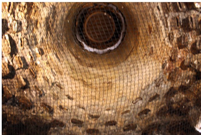
Fig. 11. Alto Horno número 2, vista del interior de la cuba, con las paredes de ladrillo refractario, donde se asoman las cajas de refrigeración. Puerto de Sagunto. 2022. Fundación de la Comunidad Valenciana de Patrimonio Industrial y Memoria Obrera de Puerto de Sagunto
