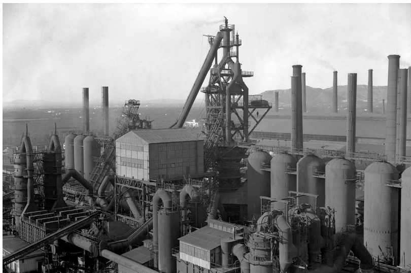
Fig. 5. Alto Horno número 2 . Puerto de Sagunto. H. 1965, Arxiu Municipal de Sagunt. Fondo Altos Hornos del Mediterráneo
