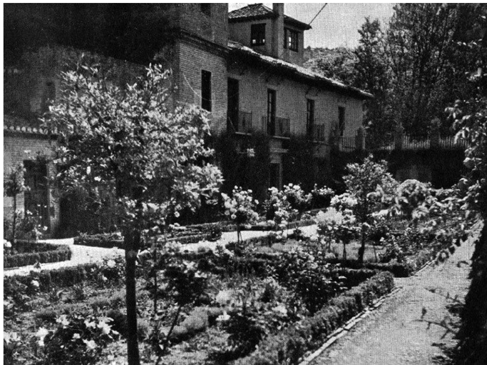
Fig. 2. Patio-jardín de la Hospedería de San Francisco . Fotografía de autor desconocido. Hacia 1945-46. La Alhambra, Granada. Revista Nacional de Arquitectura , 84 (1948), p. 493. Biblioteca COAM
