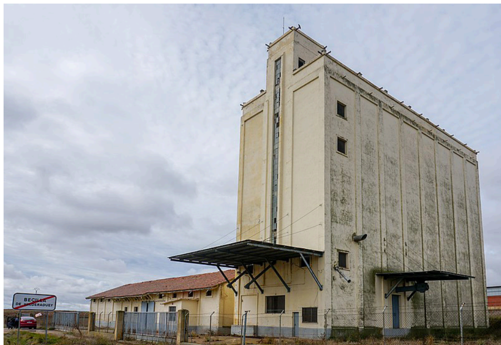
Fig. 1. Silo de Becilla de Valderaduey, edificio de tipo D
