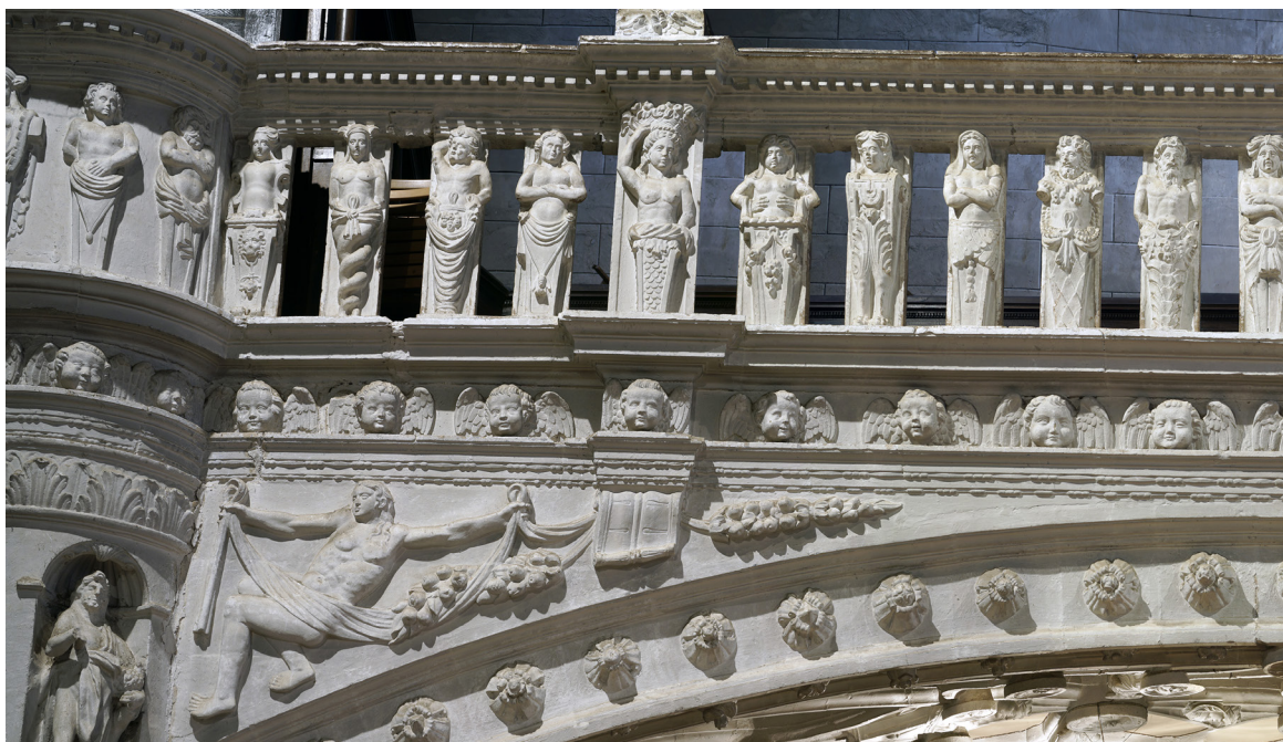
Fig. 13. Frente y balaustrada de coro. 1572-1576. Juan de Aguirre. Torralba del Río (Navarra)
