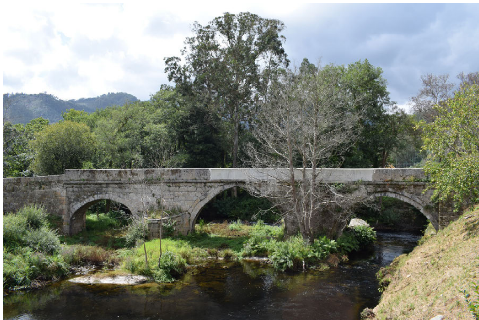
Fig. 8. Puente de Viloalle . H. 1546-1594. Reedificado parcialmente en los siglos XVII y XVIII. Mondoñedo (Lugo). [Fotografía del autor]
