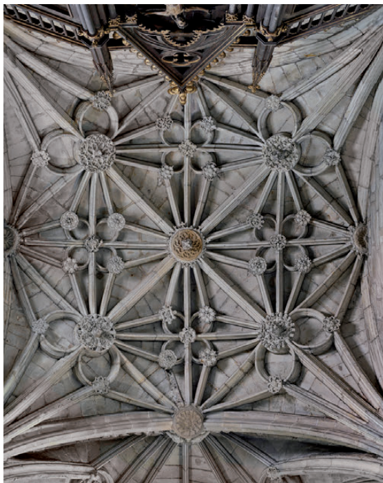
Fig. 5. Capilla mayor . H. 1519-1525. Iglesia de Santa María de Puerto, Santoña
