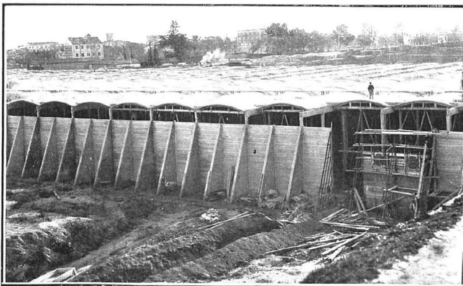
Fig. 1. Vista general del tercer depósito de aguas del Canal de Isabel II (Madrid), pocas horas antes de ocurrir el hundimiento. Fotografía H. Jalvo. 1907. *Nuevo Mundo*, 588 (13 de abril de 1905)
