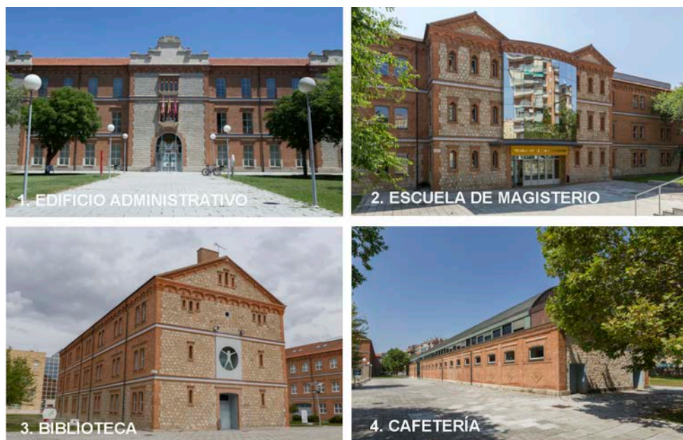
Fig. 8. Edificios rehabilitados del Campus Viriato. Zamora. Fotos: M. Hernández (Aeropol Drones)
