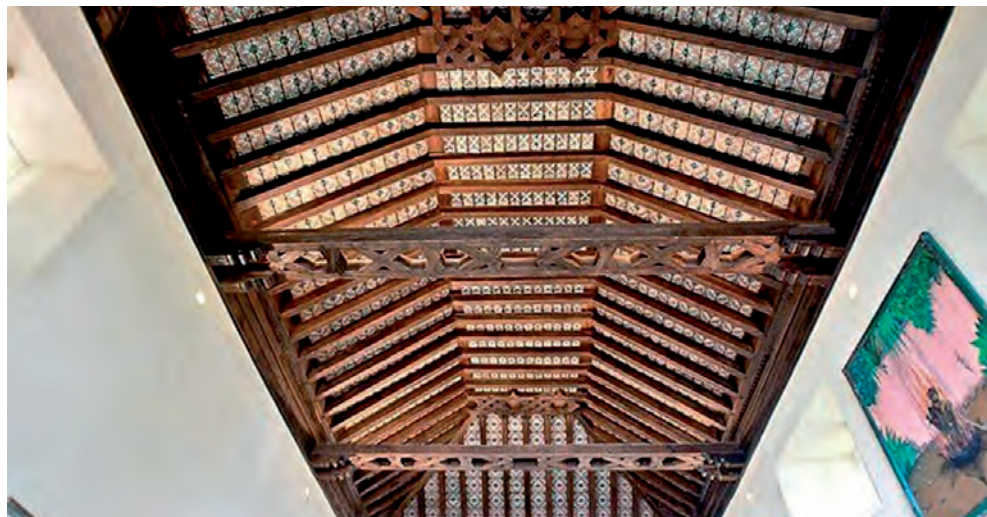
Fig. 13. Sevilian Tile Ceiling (s. XVI, Sevilla) instalado en “La Milarca”. 1999-2019. San Pedro Garza García (Nuevo León, México). Foto El Norte (Monterrey)
