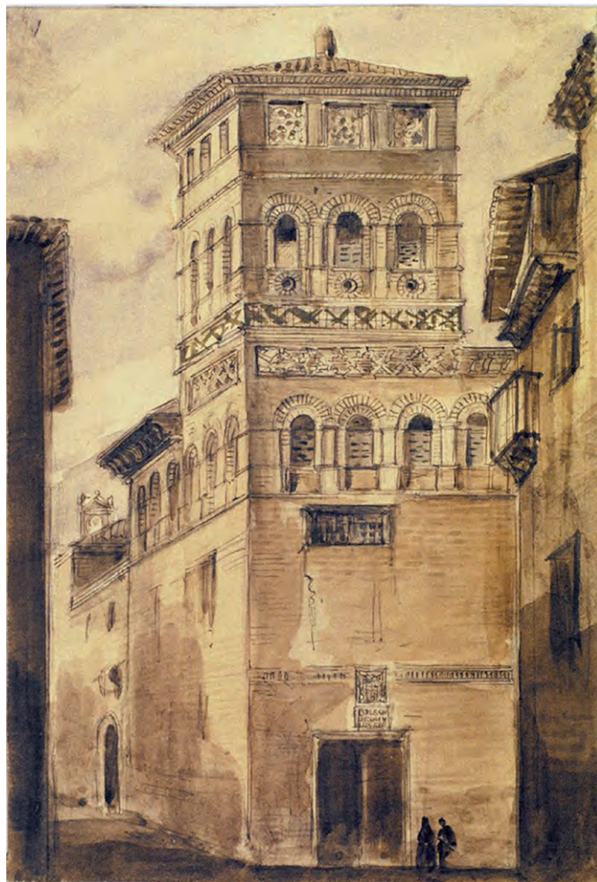
Fig. 4. Edificio del Colegio de las Vírgenes (en la izquierda, lateral de la iglesia). Valentín Carderera, hacia 1831-1880. Madrid, Fundación Lázaro Galdiano, inv. 09816
