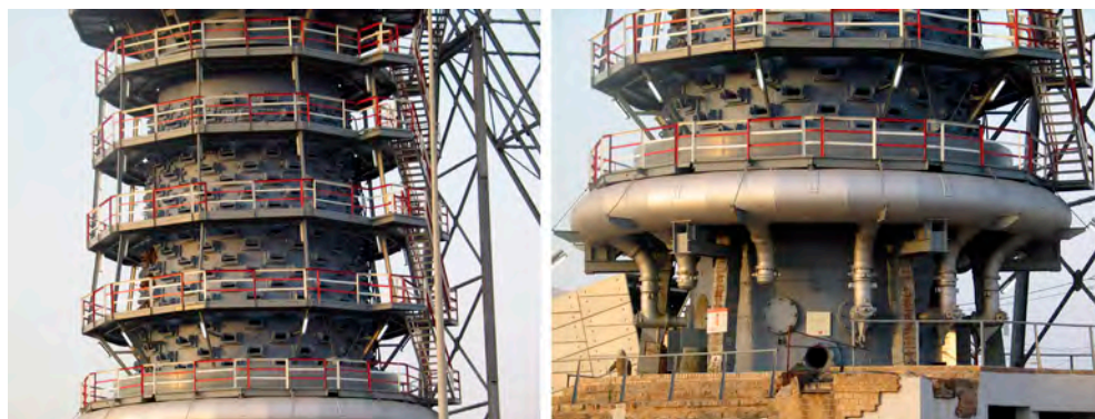
Fig. 3, izq. Alto Horno número 2, detalle de la cuba con su sistema de refrigeración compuesto por 21 filas de cajas. Puerto de Sagunto. Autoría propia. 2012
