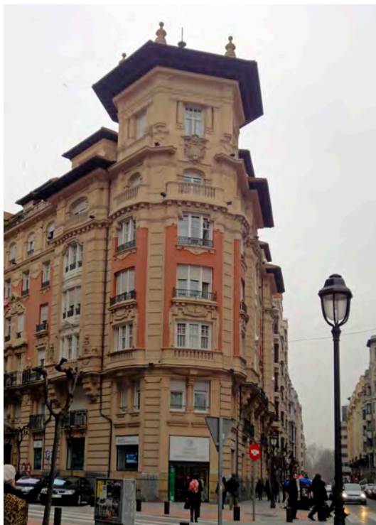
Fig. 12. Casa de Patricio Bilbao Goicoechea . Arquitecto Tomás Bilbao. 1918. Calle Ercilla nº 20. Bilbao
