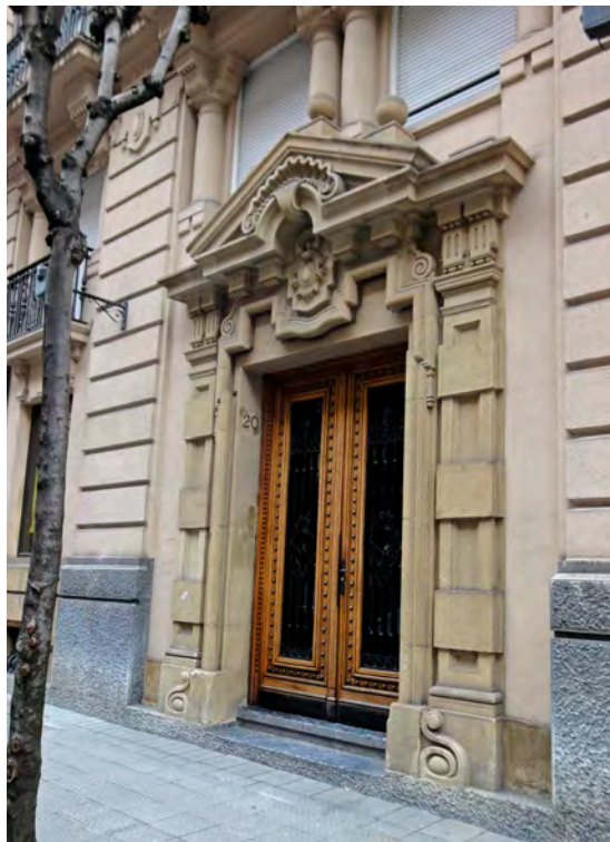
Fig. 15. Ingreso al portal de la casa de Patricio Bilbao Goicoechea. Arquitecto Tomás Bilbao. 1918. Calle Ercilla nº 20. Bilbao
