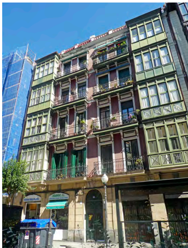
Fig. 8. Casa de Francisco Subiñas . Arquitecto Federico Ugalde. 1905. Calle Lersundi n° 2. Bilbao
