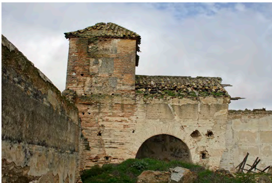
Fig. 2. Molino de Atalaya Alta (Écija) . Se trata de tapia mixta de fraga con verdugadas de ladrillo con encadenado del mismo material asentada sobre un sobrecimiento también de ladrillo. Las tapiadas tienen una altura de 83 cm correspondiente a un módulo bajo (aproximadamente una vara) con talud de junta oblicuo y vertical en la nave y sin juntas en la torre de contrapeso. El número de hiladas es de cinco en la nave almazara y de tres en la torre de contrapeso, sirviendo para el arranque de las tapiadas en ambos casos los machones de ladrillo como frontera. La coronación de la torre de contrapeso se ejecuta sin zuncho mientras que en el caso de los muros de la nave se hace con zuncho de ladrillo donde se introducen las colañas. Respecto al encofrado, el tapial utilizado para ambos casos es de cajones, localizándose los agujales donde se introducían las agujas pasantes y recuperables, en las verdugadas de ladrillo conformando un cajeado rectangular. Fotografía de los autores. 2020
