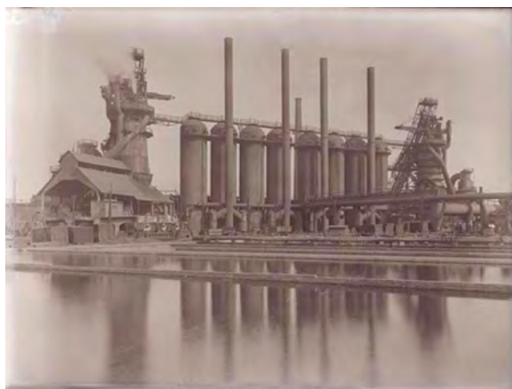
Fig. 1. Altos hornos nº 1 y 2 y balsas de enfriamiento. Vicente Barberá Masip. H. 1928-29. Biblioteca Valenciana Nicolau Primitiu. Fondo Desfilis. Fuente: BIBALDI
