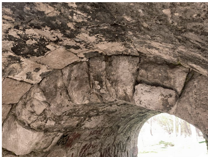
Fig. 8. Portillo de la calle de la Pedraja desde el interior. Se aprecia un doble arco: el medieval es el original, más bajo. El reconstruido en la intervención de 1679, presenta mayor altura. Fotografía del autor
