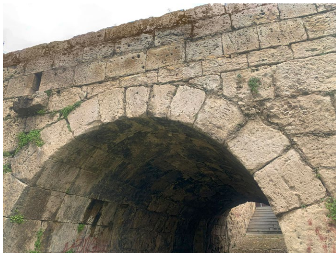
Fig. 7. Portillo de la calle de la Pedraja. Reconstruido parcialmente en 1679 por Juan Alonso de Estrada. Se aprecia talla distinta en parte de las dovelas, especialmente en la franja izquierda, porque los de la derecha son de mayor antigüedad. Se aprecia en la fotografía el desaguadero o vierteaguas, en el ángulo superior izquierdo, al que hacen referencia las condiciones
