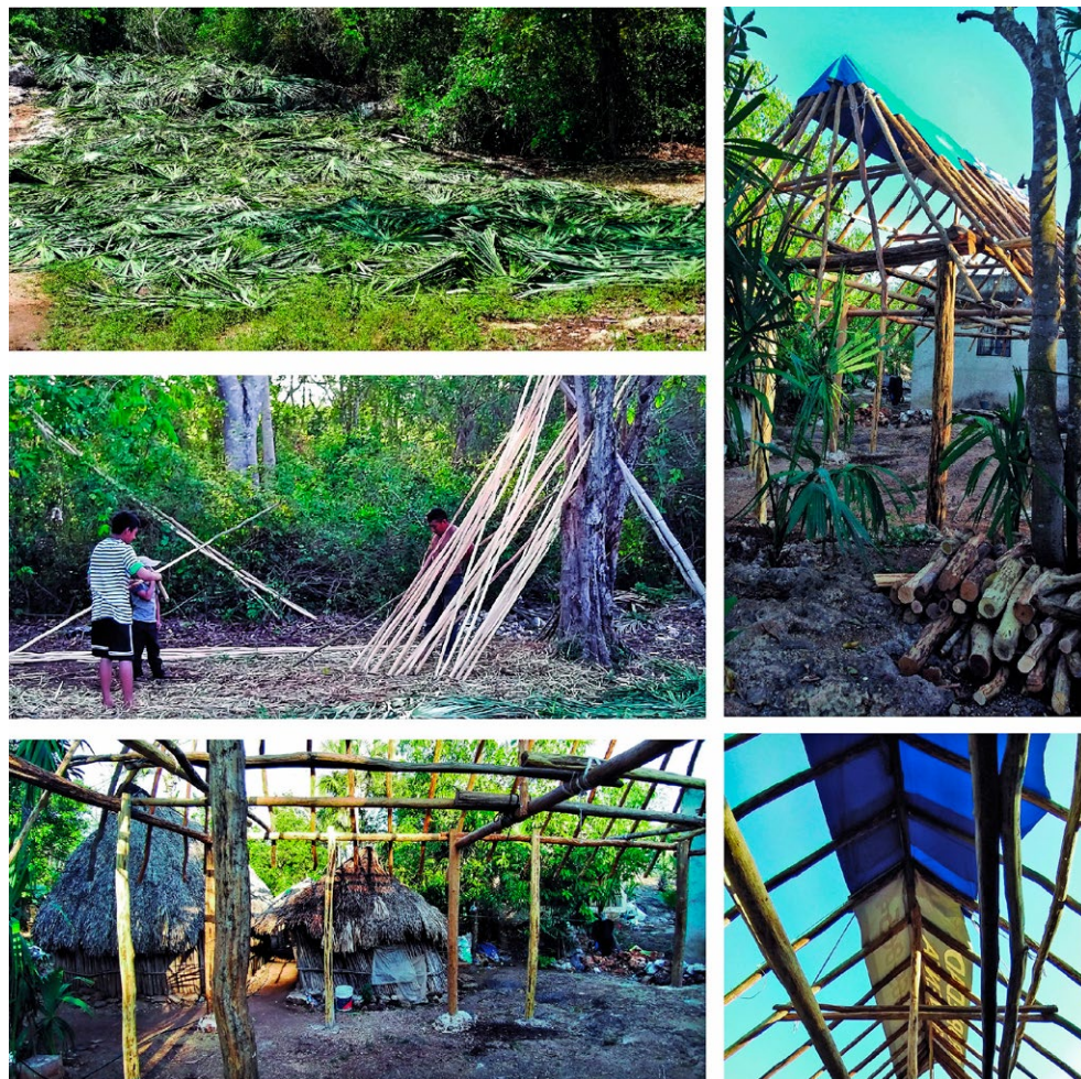
Fig. 6. Materiales naturales y proceso constructivo empleados en la habitación maya, un organismo vivo
