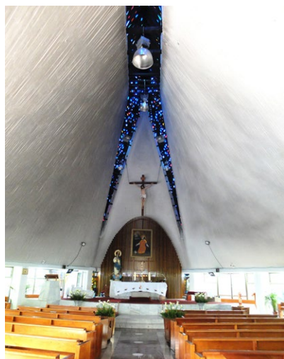
Fig. 21. Iglesia de la Inmaculada Concepción (interior) . Alberto González Pozo y otros. 1964-1984. Colonia El Reloj (Coyoacán, Ciudad de México). Foto del autor
