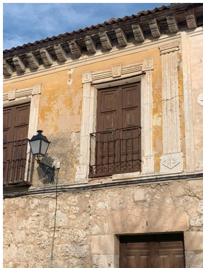
Fig. 11. Detalle del palacio del duque de Osuna, en la calle homónima. Se aprecia un piso inferior de mampostería y puertas de sillería sobre el cual se asientan los cuartos principales del palacio, son sus ventanas y balcones del siglo XVIII, enlucidas y trabajadas con molduras de escayolas. Fotografía del autor
