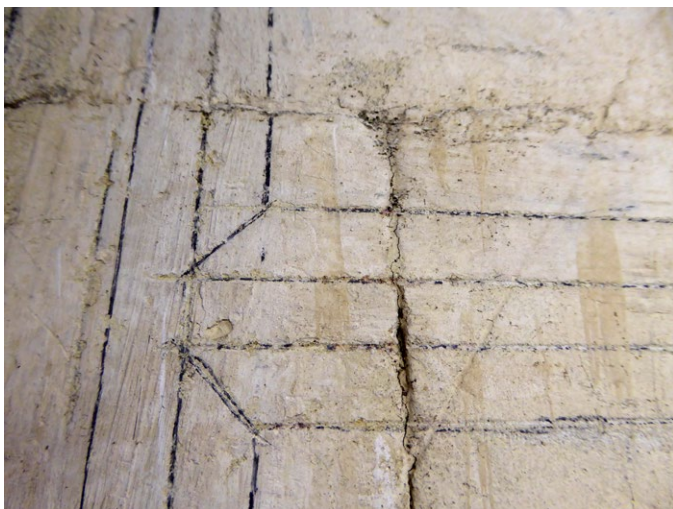
Fig. 2. Detalle de la montea para la librería de la Biblioteca General Histórica de la Universidad de Salamanca que está incisa y remarcada con grafito. Fotografía: Alexandra M. Gutiérrez-Hernández
