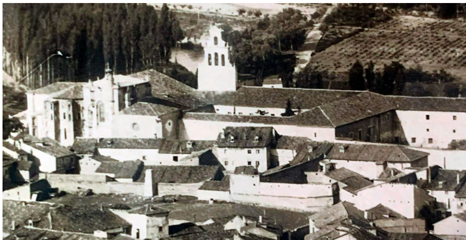
Fig. 10. Vista del palacio de los marqueses de Peñafiel desde el castillo. En el centro de la imagen, por delante del claustro del convento de San Pablo, se aprecia el bloque principal del palacio, más elevado, seguido, a la derecha con unos cuartos con mirador que llegan hasta la capilla de los Manuel y, a la derecha, otros cuartos que llegan hasta la plaza de San Miguel de Reoyo
