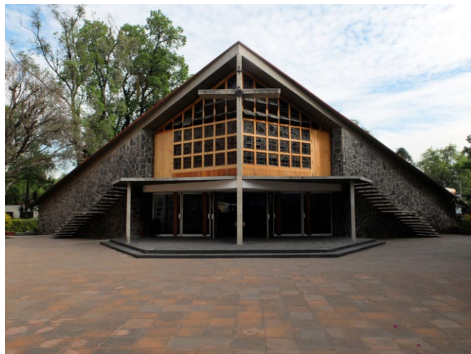
Fig. 3. Capilla de San José del Altillio . Félix Candela y otros. 1955-1957. Coyoacán (Ciudad de México). Foto del autor
