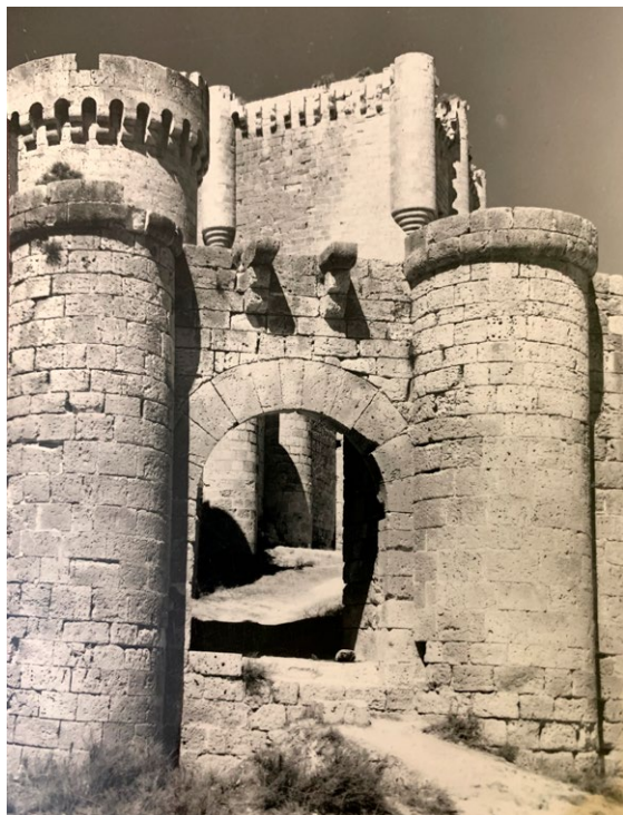
Fig. 1. Postal antigua (ca. 1900) que muestra la entrada principal de la fortaleza, lugar donde se llevó a cabo la intervención de cantería, en 1583. Ediciones Sicilia, Zaragoza. Colección del autor
